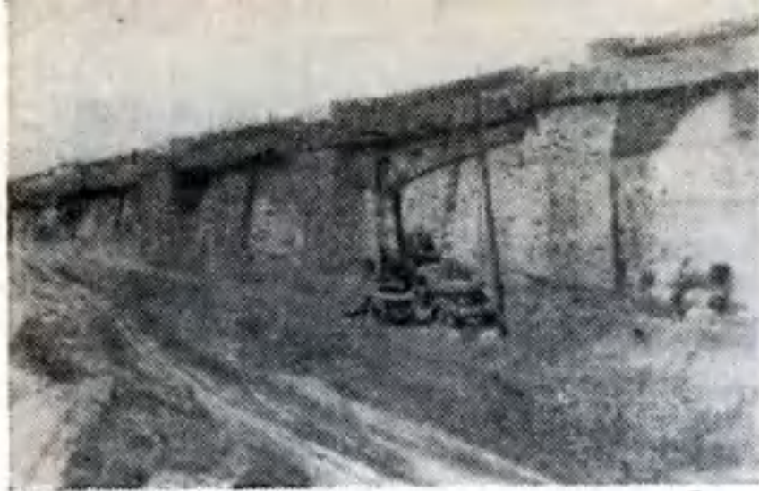
Эти бетонные стены — «берега» будущего шлюза.
